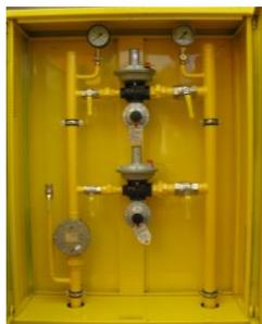
ШГРП выпускаются ООО «Италгаз» согласно ТУ У 29.1-32752712-001:2006 (с изменениями 2013 года) с одной или двумя линиями редуцирования, в их состав могут входить фильтры, манометры и термометры. Для учёта газа используются соответствующие счётчики и, при необходимости, корректор расхода. Ящики окрашены порошковым методом в специальных камерах.
