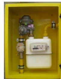
Пункты шкафные газорегулирующие (ШГРП) предназначены для снижения и поддержания давления газа на заданном уровне, а также коммерческого учёта потребления газа при газоснабжении промышленных и коммунально-бытовых объектов.
